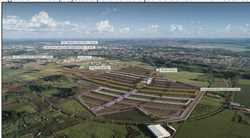
Figura 3 – Área projetada para construção do Condomínio Hectares
