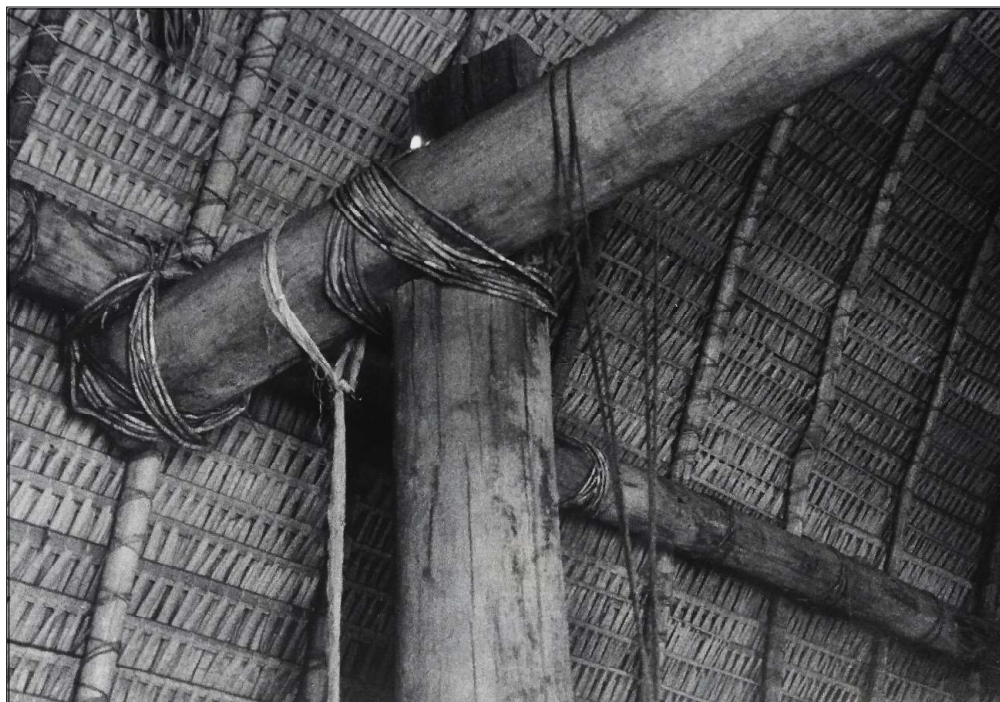
Figura 6 - “y, por la parte de abajo, que es de la casa parecen esteras [...]” 8-10 folhas por metro quadrado, e exemplos de amarrações dos componentes estruturais e da cobertura (interior de construção Asurini do Xingu)
